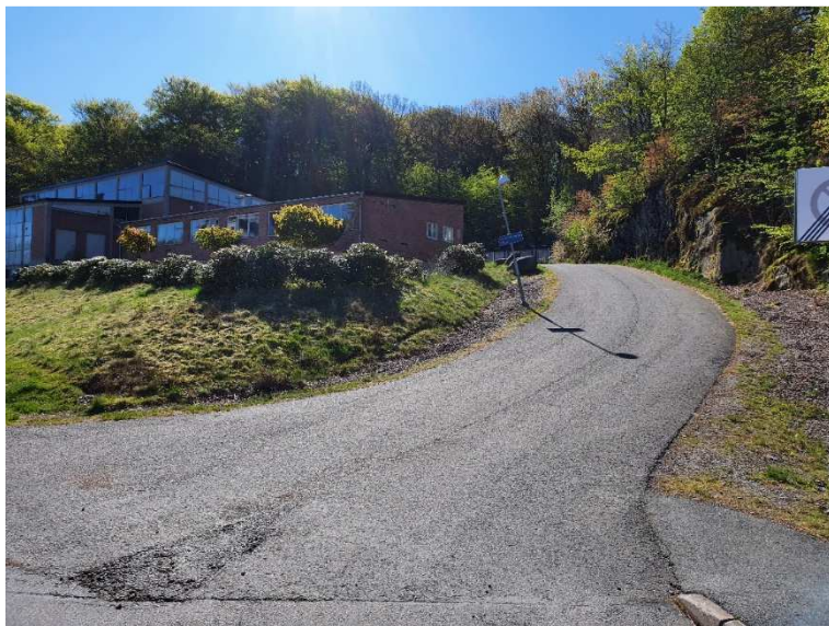
Figur 5. Östra området: Panncentralen och övriga byggnader på fastigheten Backa 866:831 och 866:847.
